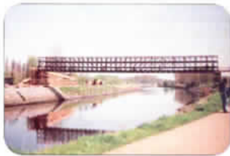
De baileybrug over de Schelde na de plaatsing.
