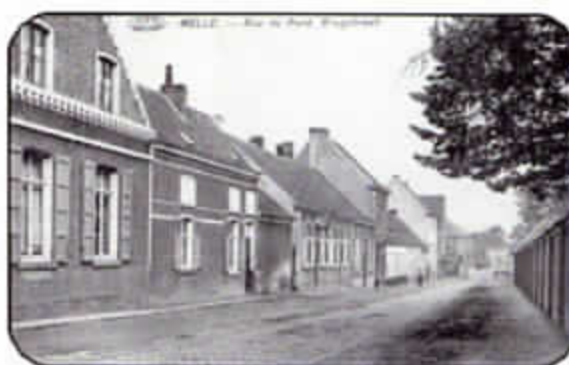
Rechts: de omheiningmuur aan de zijde van de Brugstraat.
